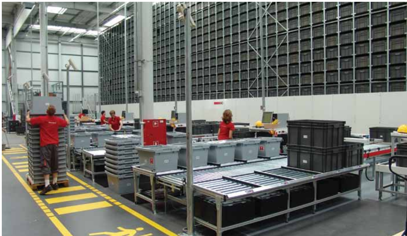
Im AKL arbeiten drei TGW Mustang Regalbediengeräte mit Lastaufnahmemitteln vom Typ Kombiteleskop, für doppelte Lagerung ausgestattet.
